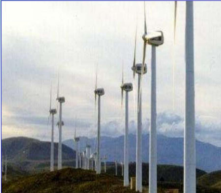
**Le centrali eoliche sono formate da torri d'acciaio alte cento metri e munite di eliche con un raggio di 40 metri: secondo alcuni deturpano il territorio; in compenso, però, gli impianti eolici possono essere smantellati senza lasciare danni**
